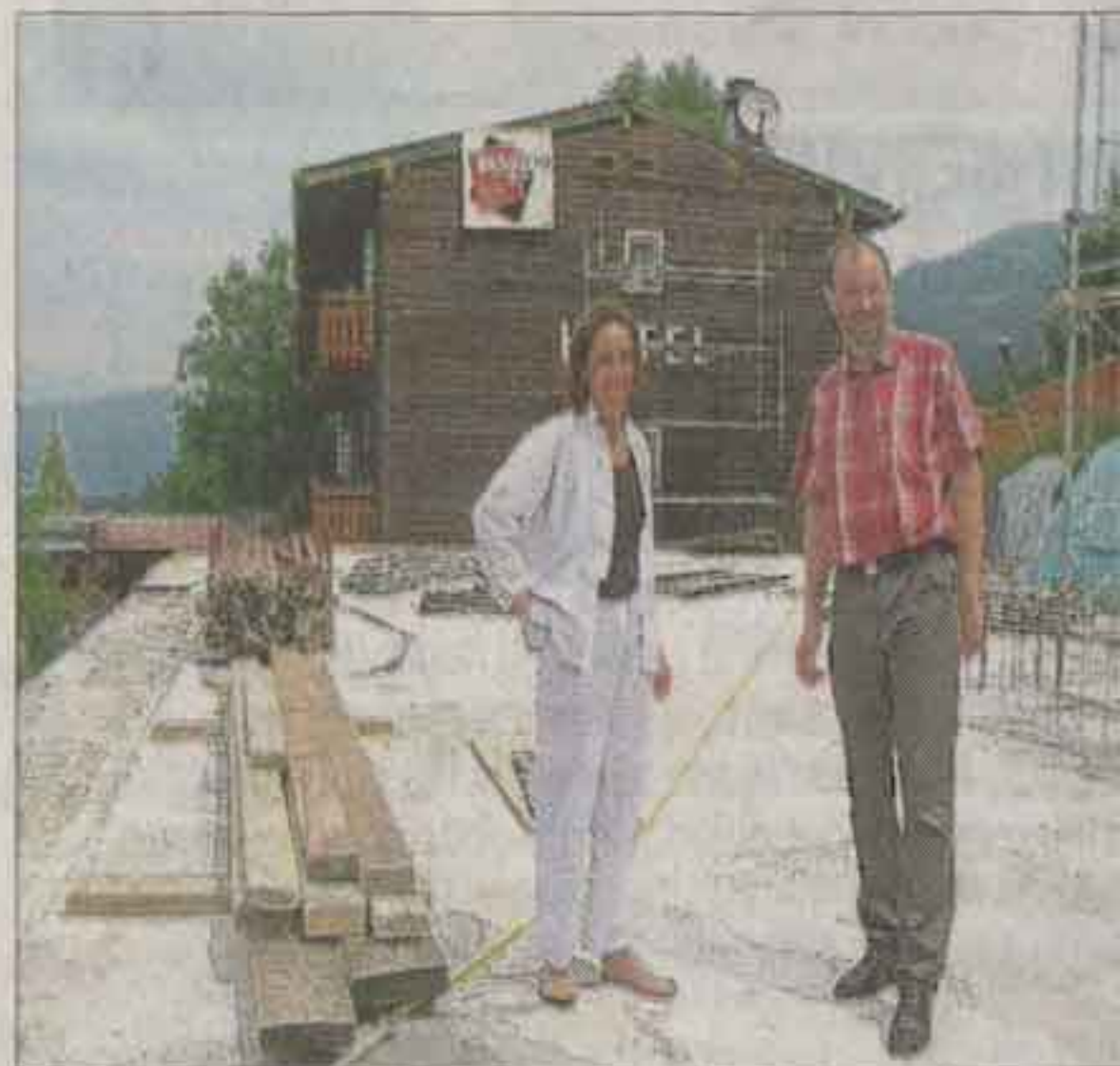
« Le chantier a été lancé en mai dernier, et se déroulera en deux phases », précise Jean-Marc Tiret, ici avec l'architecte Corinne Mermillod.
